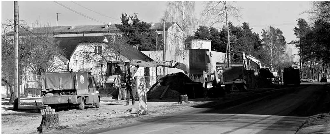
Remontdarbi Rīgas ielā. Zanes Siliņas foto
